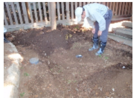
③除去した土を埋設
