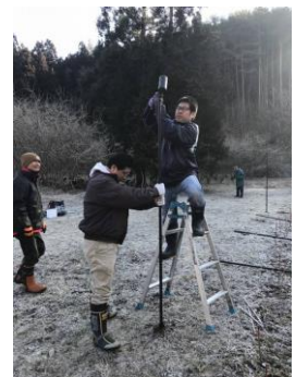
その穴に、支柱を打ち込みます。
