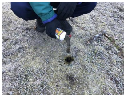
気温は、マイナス5度。 土が凍っているので、バーナーで 溶かして穴を開けます。
