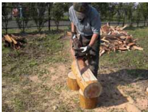
上面側をギリギリの深さで切り抜く。
